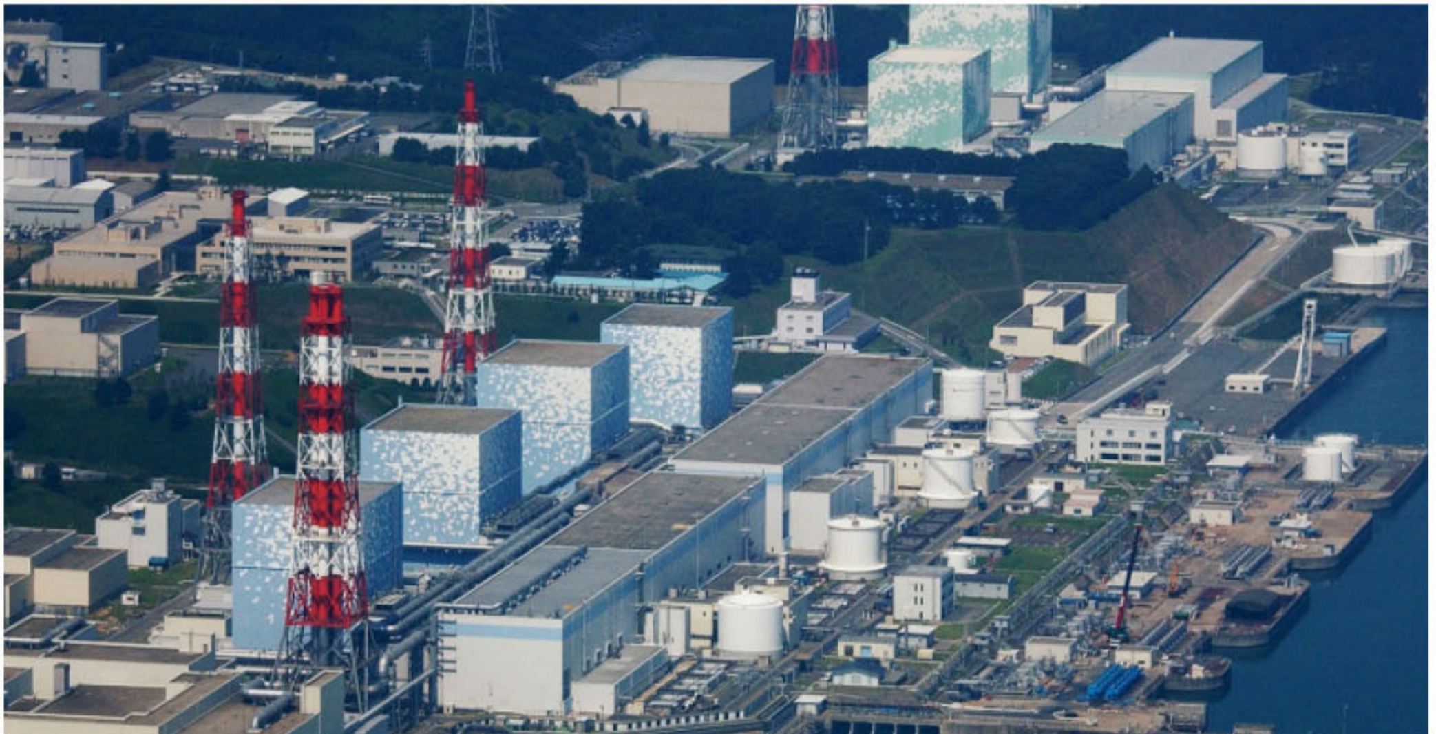
福島第一原子力発電所
