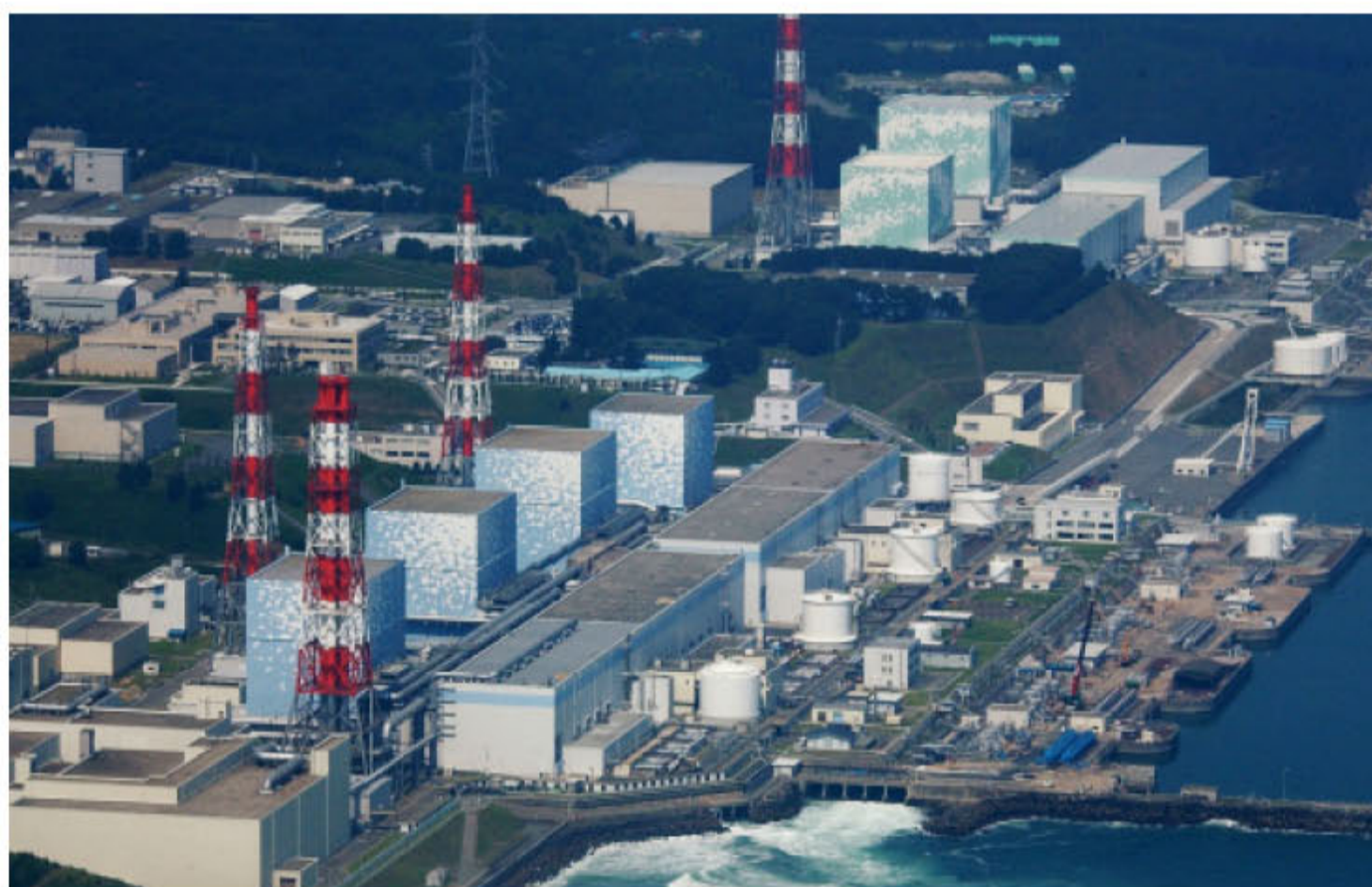
福島第一原子力発電所
